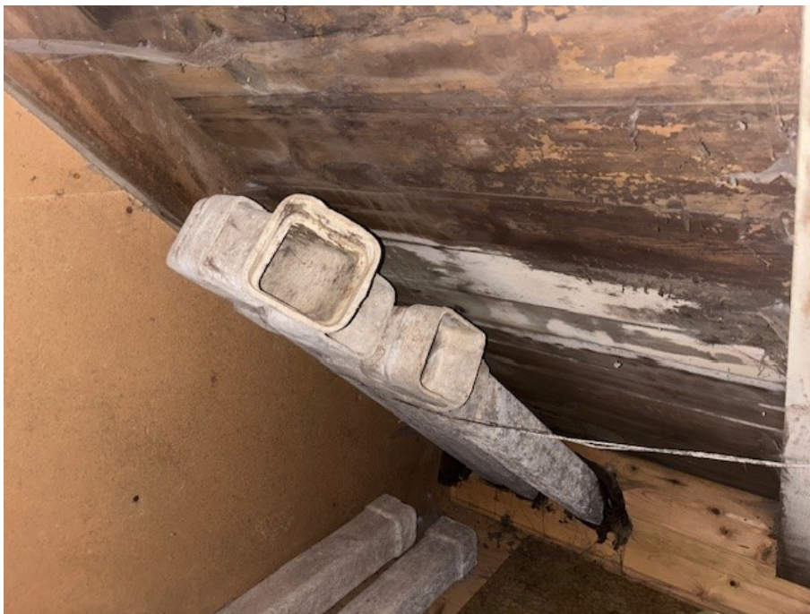
Mikrobiell påväxt på underlagstakets insida på vinden och öppna ventilationskanaler på vinden.
