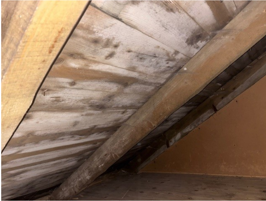
Mikrobiell påväxt på underlagstakets insida på vinden och öppna ventilationskanaler på vinden.
